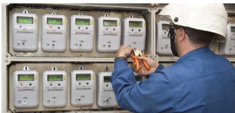
Un operario coloca contadores de la luz. / C. J. CASTILLO
